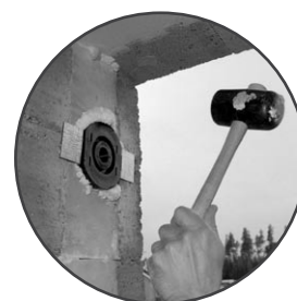
3. Karmikiinnikkeen kiinnitys
